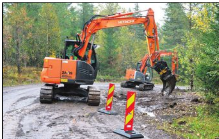
GRØFTING: Det er mange oppgaver som skal utføres for å holde en vei i orden. Her jobber elevene med å grøfte Merkedamsveien.
